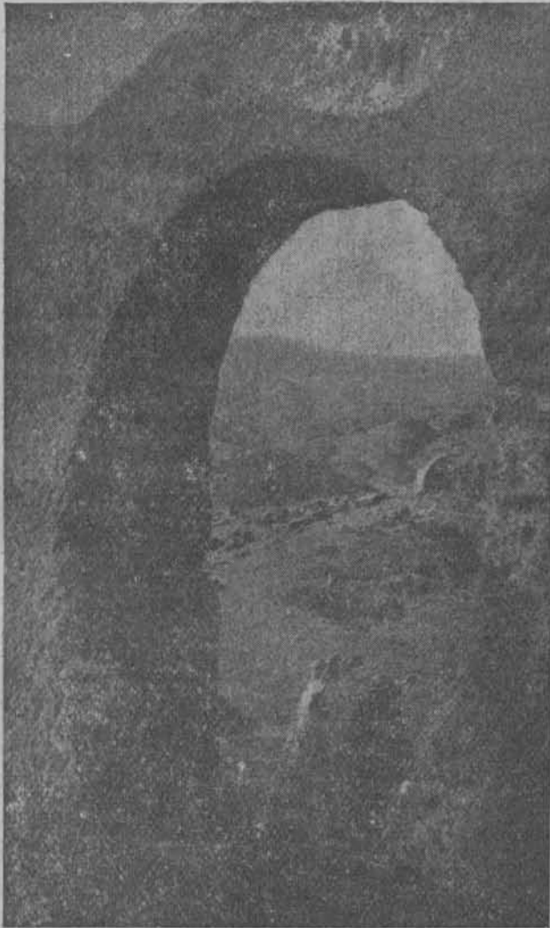
Arco de la nave central del templo
