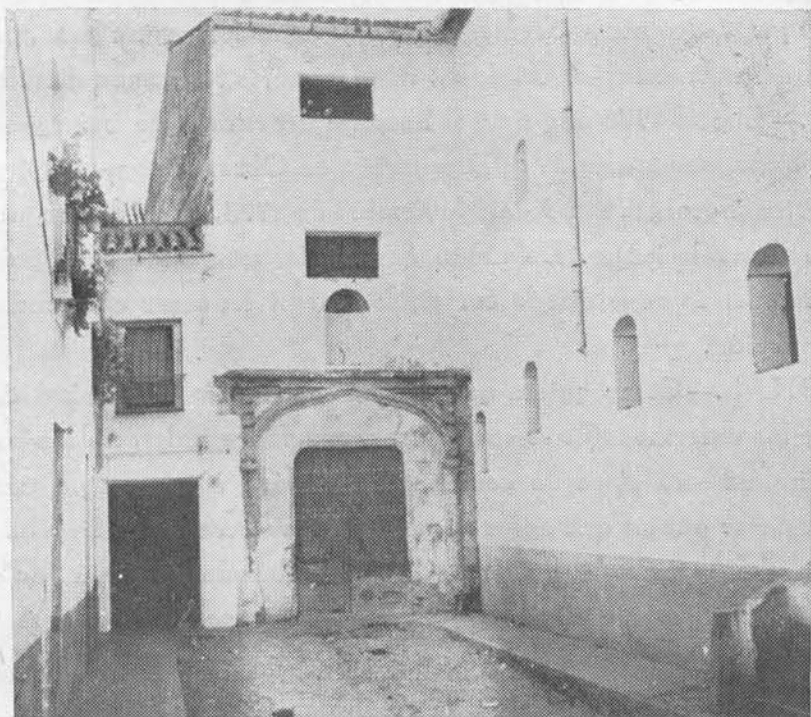
(Fig. 28). Puerta principal de entrada al hospital de Convalecientes de San Francisco. Hoy falsa de Expósitos.
