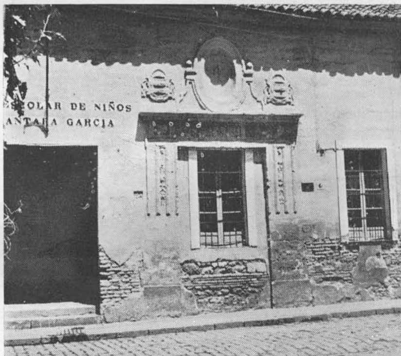
(Fig. 22.) Hospital de San Andrés (Condes de Gavia). Primer Emplazamiento. La ventana del centro de la fotografía fué indudablemente la puerta principal del mismo. Hoy grupo Escolar.
