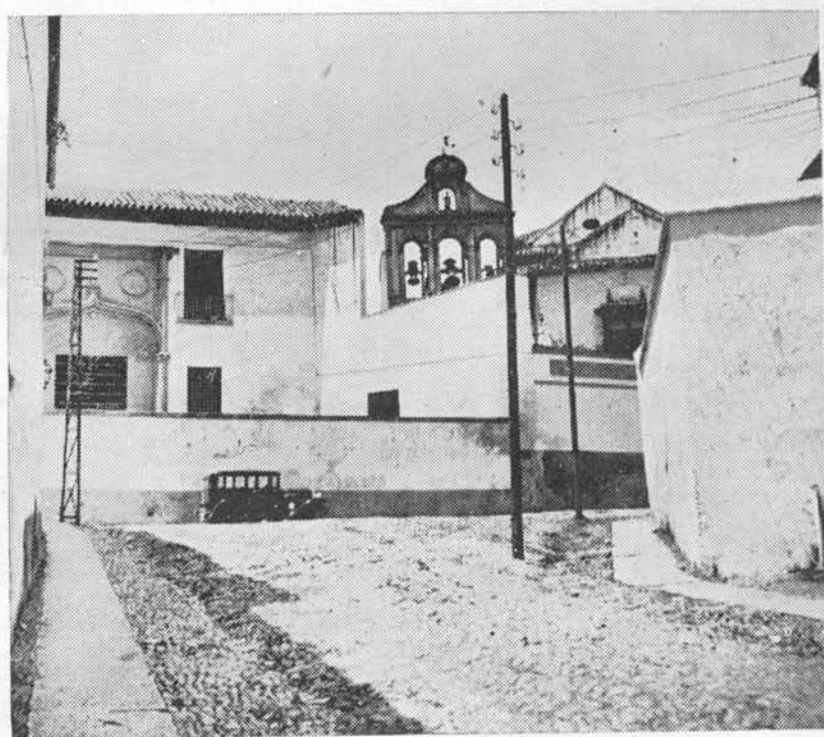
(Fig. 25). Hospital de S. Juan y S. Jacinto. Vista de conjunto—, iglesia campanario, edificaciones—, tomada desde la Cuesta del Bailío.
