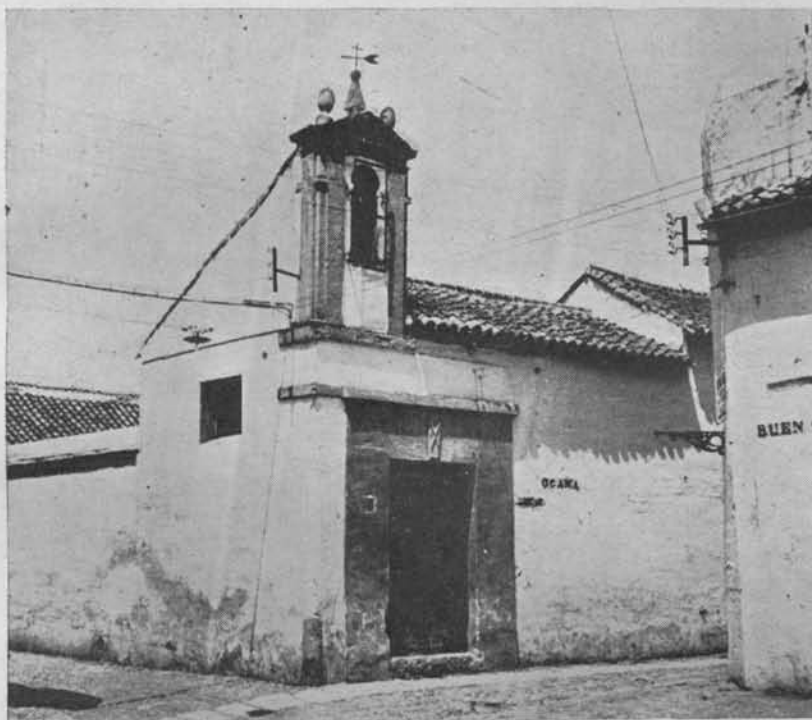
(Fig. 12.) Hospital de San Andrés (Buen Suceso). Sobre la puerta aparece la Cruz aspada de San Andrés
