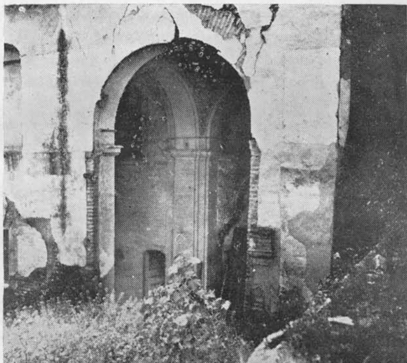
(Fig. 20.) Parte inferior de las mismas ruinas
