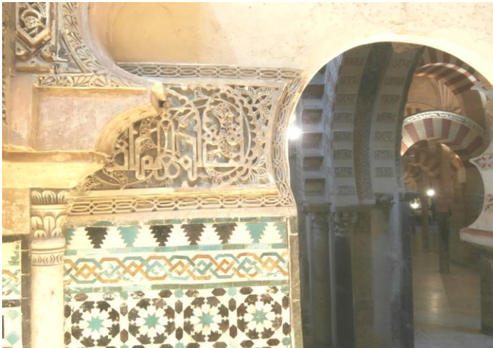
Fig. 24. La segunda entrada antigua a la Capilla Real
