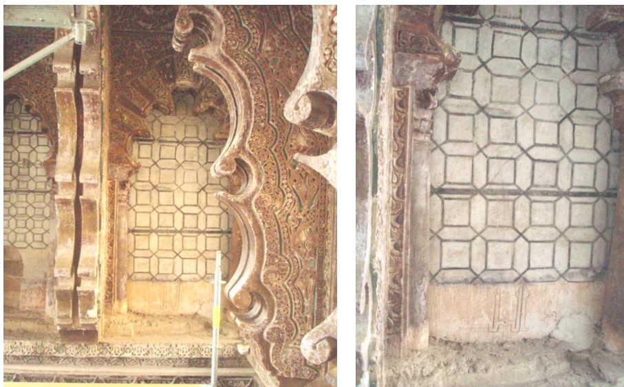
Figs. 35 y 36. Ventanales de la Capilla Real
