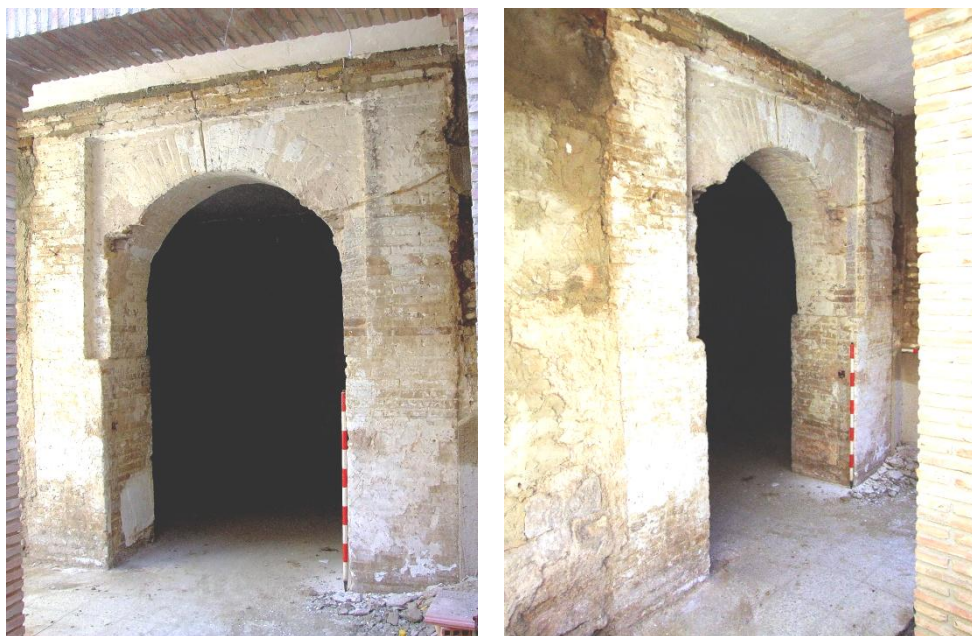
Láms. I y II. Vista del arco mudéjar del muro 6 desde el patio del inmueble (cara sur)
