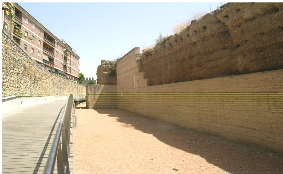
Restos de muralla del Alcázar Viejo, en restauración
