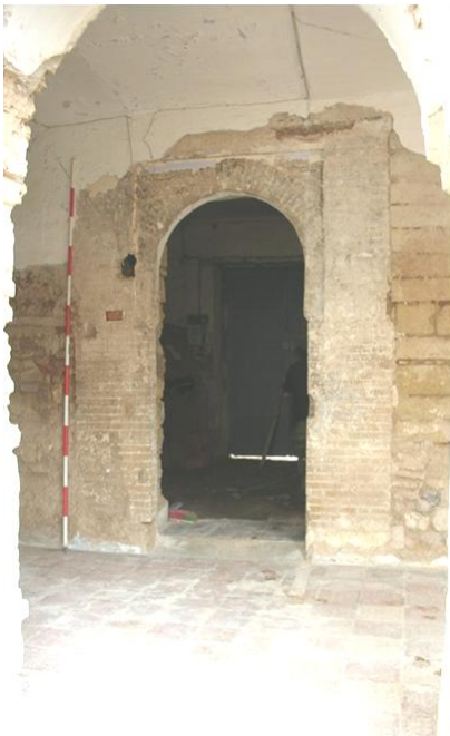
Fig. 1. Calle Moriscos n.º 28 (fotografía M. Martín)
