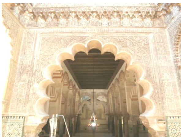
Fig. 29. Arco lobulado del muro Sur
