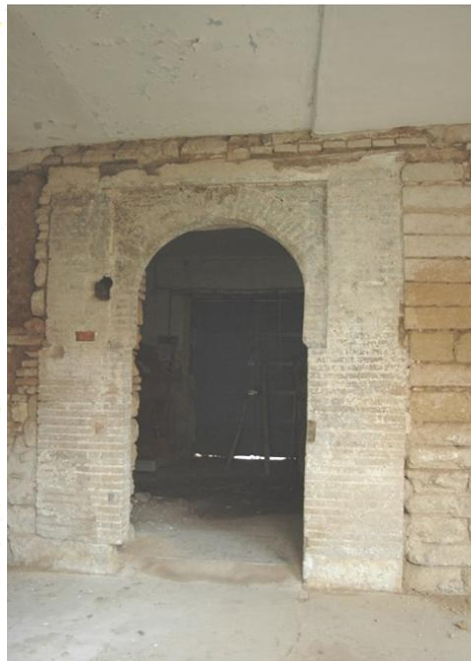
Fig. 2. Calle Moriscos n.º 28 (fotografía Oficina de Arqueología GMU)
