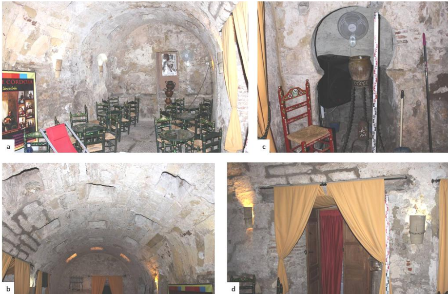
Fig. 6. Sala caliente (Fotos: J. M. Tamajón). a) Vista de los lienzos noroeste y sureste; b) Bóveda de cañón con lucernas; c) Arco de herradura de la saleta lateral meridional; d) Vano de comunicación entre las estancias templada y caliente
