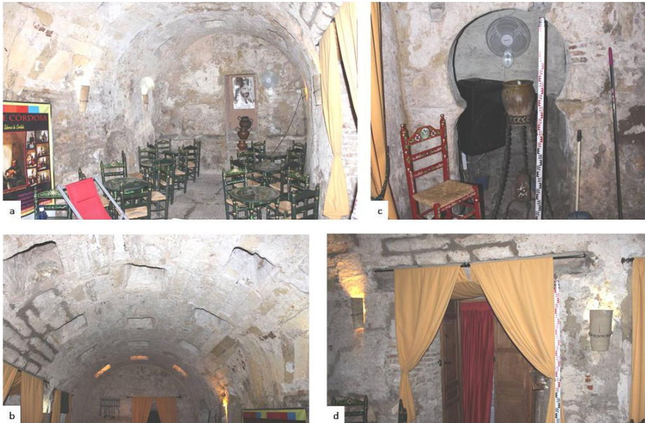
Fig. 6. Sala caliente (Fotos: J. M. Tamajón). a) Vista de los lienzos noroeste y sureste; b) Bóveda de cañón con lucernas; c) Arco de herradura de la saleta lateral meridional; d) Vano de comunicación entre las estancias templada y caliente
