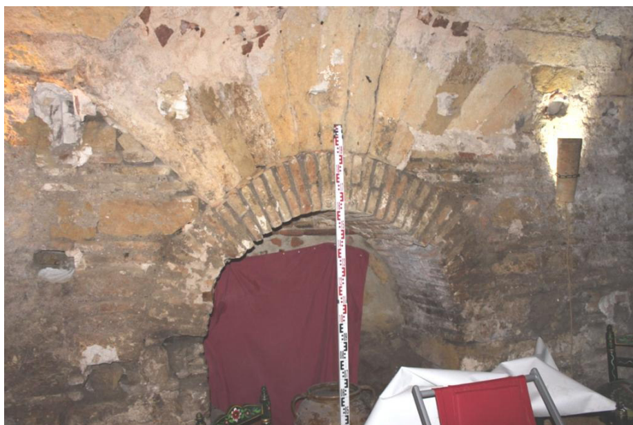
Fig. 7. Detalle de los arcos y aparejos de la pared suroeste de la sala caliente. (Foto: J. M. Tamajón)
