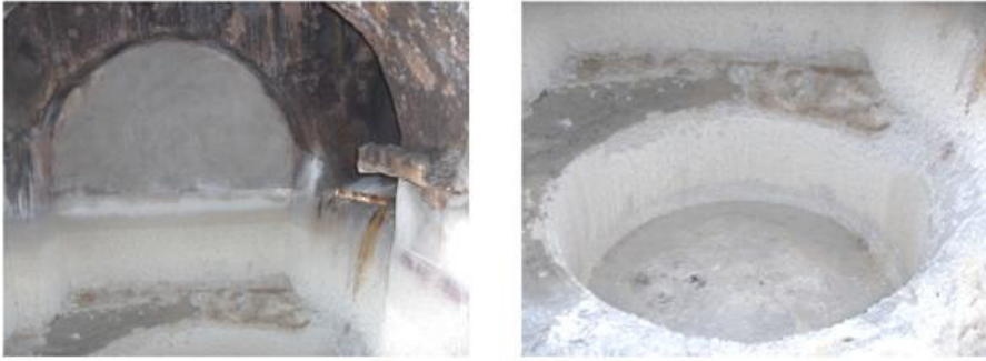
Figura 5. Vista de una sala de almacenamiento de agua con bóveda de cañón de ladrillo arriba y una caldera cóncava Fuente: Disli (2008)
