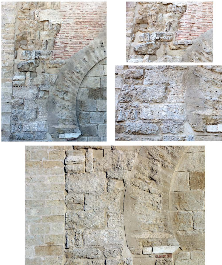
Figura 8.- Detalles del aparejo a soga y tizón, con huellas de sillares almohadillados, correspondientes a la fábrica de la puerta omeya.
