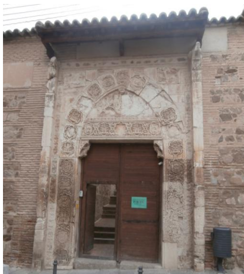
Fig. 15 Entrada del convento de Santa Isabel
