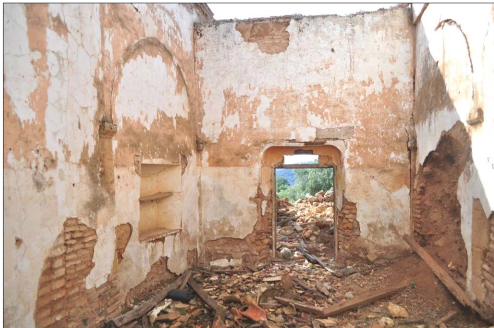
Fig. 4. Arcadas tapiadas de la nave principal de la posible ermita. Vista al oeste (2012-10-03).
