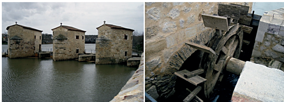
Figura 18. Aceñas de Olivares y rueda de paletas planas.
