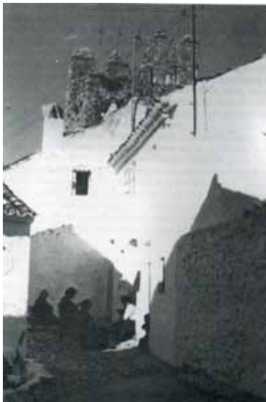
Una calle del Barrio de la Torre antes de la reforma que hizo D. Cludio Tallón Cantero.
