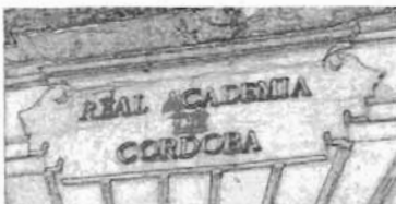
"Estamos a la espera de que el Ayuntamiento acometa las obras de reparación del edificio que tiene cedido a la Academia para hacerlo útil, y libres de trabas administrativas las obras del edificio contiguo"
