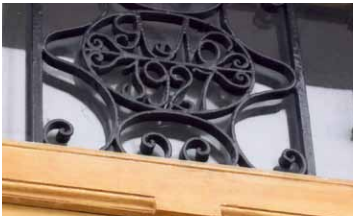
Letero existente en lo alto de la puerta de entrada del Ayuntamiento de Zuheros: año 1927 fecha de terminación del Ayuntamiento, y Juzgado Municipal, Escuelas de niños y niñas, casa de los Maestros Nacionales. Arquitecto D. Manuel Latorre Pastor.
