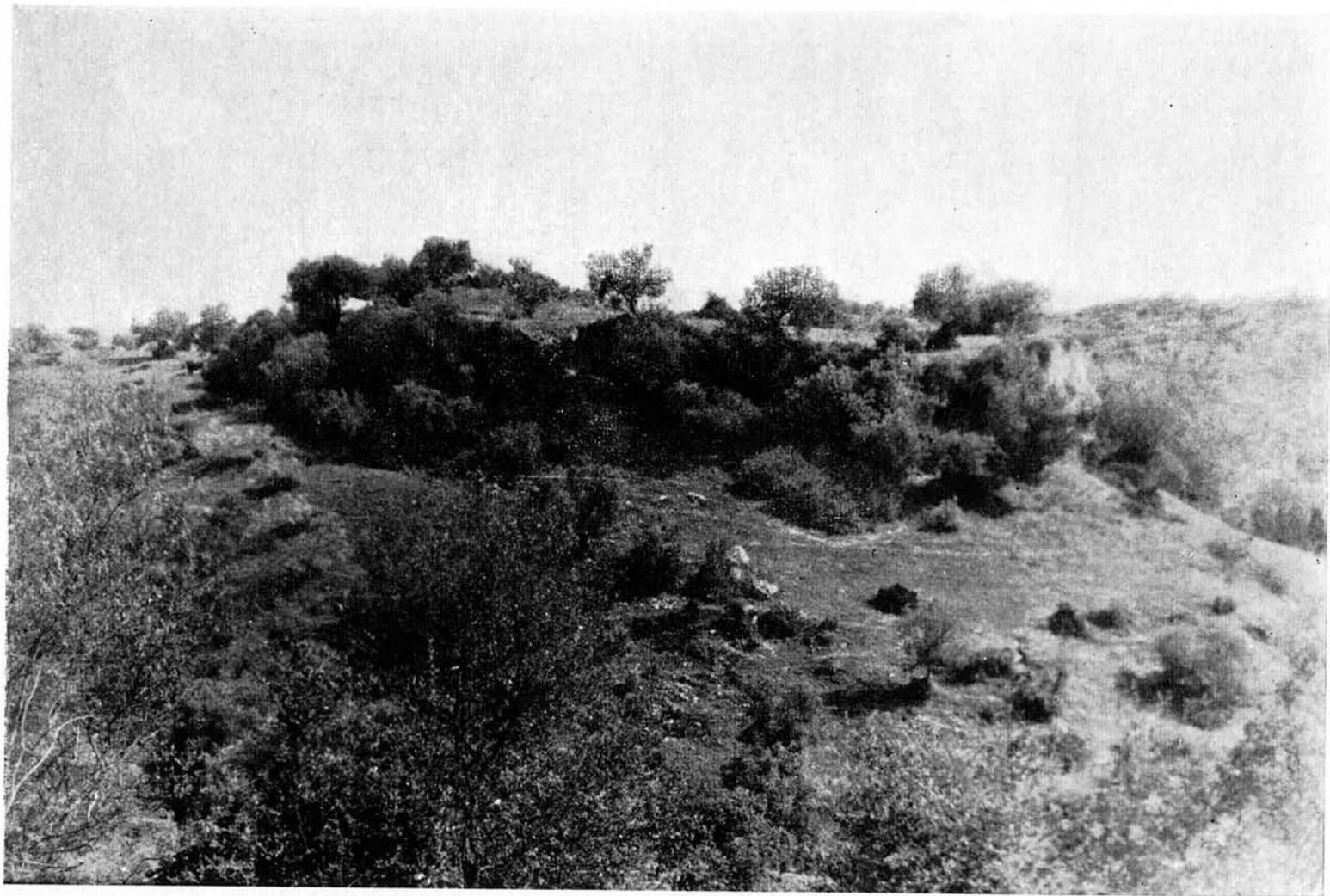
CASTILLO DE TOLEDILLO. — VISTA DE CONJUNTO, FIGURANDO EN PRIMER TERMINO LA MURALLA MERIDIONAL DEMOLIDA Y A SU EXTREMO AFLORA EL TORREON SURESTE
