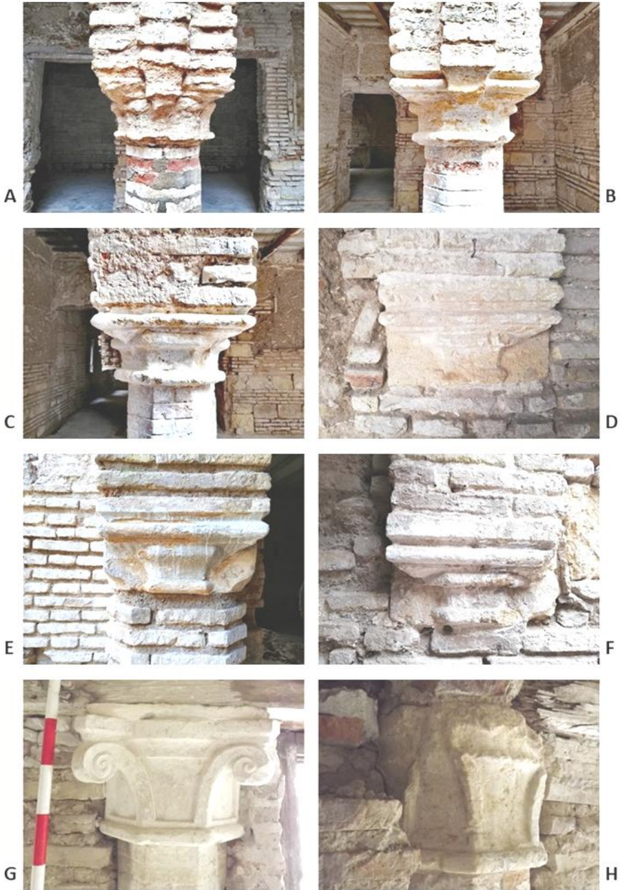
Figura 7. Detalle de los capiteles y cimacios de la galería mudéjar de Calleja de las Flores
