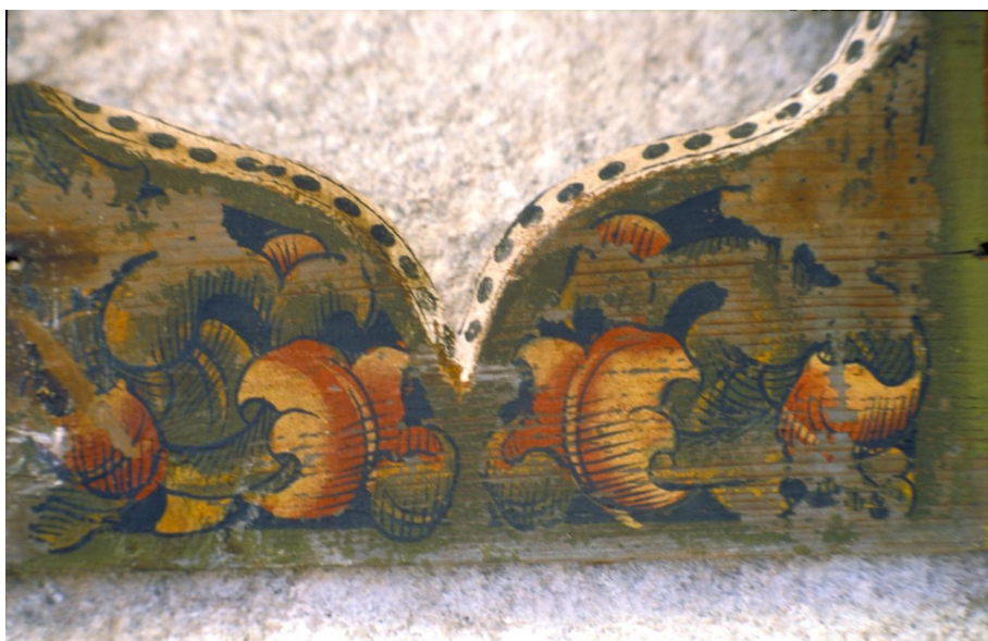
Il. 5. M. a Ángeles Jordano Barbudo. Tablilla con decoración de cardinas correspondiente a un alfordón de perfil conopial perteneciente a un alfarje. Convento de Santa Clara de la Columna. Belalcázar (Córdoba)
