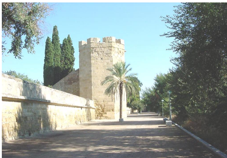
Fig. 2. Vista del paseo tras la última intervención de adecuación del espacio. ET. Murallas de Córdoba III. GMU.
