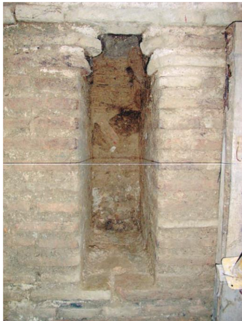
Figura 9. Boca de una tobera de tiro del hipocausto. Fuente: López Osorio y Torres Carbonell (2008)
