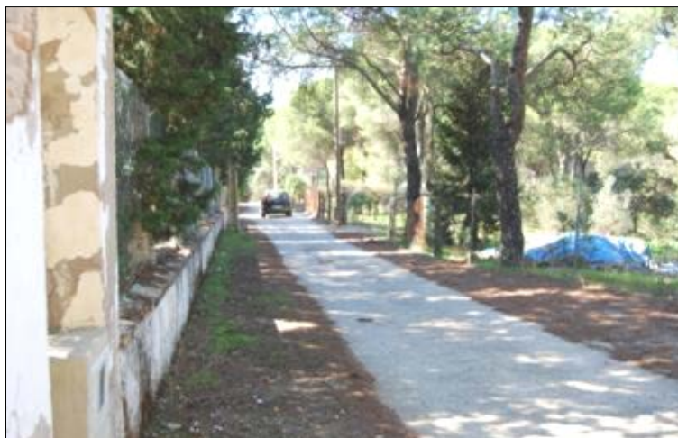
Figura 12. Las vías de circulación con poca anchura donde no es posible el tránsito en dos sentidos simultáneos ni la presencia de más de un vehículo no permiten el paso de los vehículos de extinción cuya anchura es mayor a los convencionales. Fuente: Clara Quesada, 2009.
