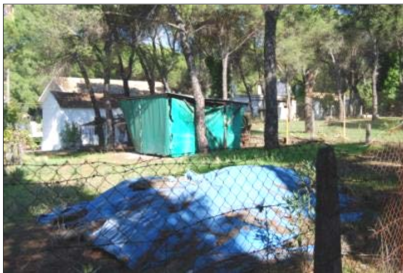
Figura 14. La acumulación y tendencia a acumular todo tipo de elementos y materiales combustibles en torno a las viviendas y edificaciones, muchas veces desechos y elementos sin valor aumentan la vulnerabilidad de las estructuras. Fuente: Clara Quesada, 2009.
