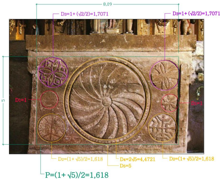
Fig. 25. Mesa de altar visigoda o mozárabe en Santa María de Lebeña. No es aleatoria, sino expresamente intencionada, la secuencia de los diámetros de los círculos representados: D1=1 ; D2= (1+\sqrt{5})/2=1,618 ; D3=1+(\sqrt{2}/2)=1,7071 ; D4=2\sqrt{5}=4,4721 y D5=5 . Igualmente el rectángulo de la mesa tiene la proporción [P= (1+\sqrt{5})/2=1,618] , llamada proporción "áurea".
