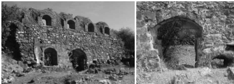
ils.5 y 6. Muro de la portería del convento y detalle de la puerta.
